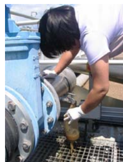
Figura 4.14. Detall de la recollida de mostra del reactor biològic.
