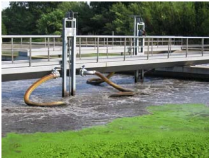
Figura 4.3. Reactor biològic.
