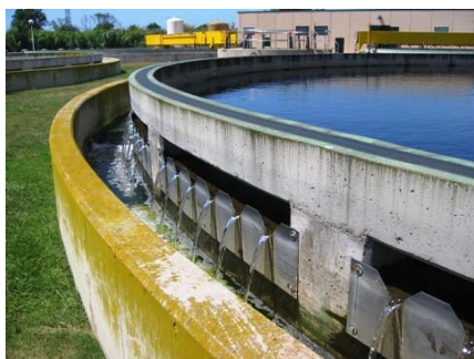
Figura 4.15. Decantador secundari.
