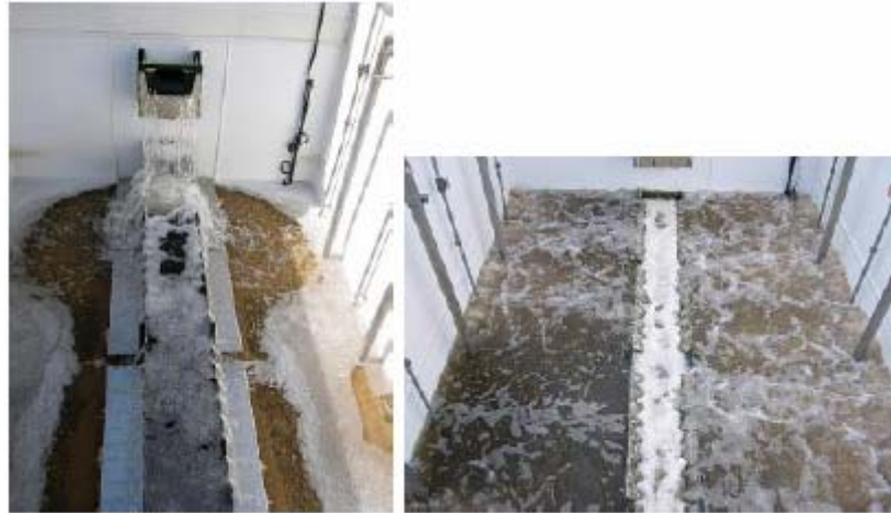
Figura 2.6. Filtració de l'efluent secundari a la planta de regeneració. Funcionament normal del filtre (esquerra) Filtre en fase de contrarentat (dreta) [58].
