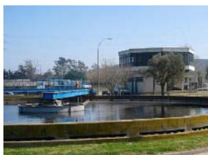
Figura 4.20. Decantador secundari.
