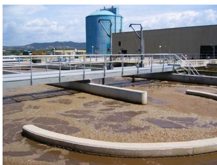
Figura 4.13. Reactor biològic.
