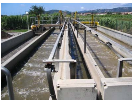
Figura 4.12. Tractament primari, desarenador-desengreixador.
