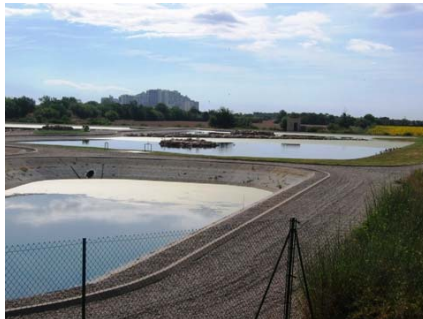
Figura 4.6. Llacunes de sedimentació i d'afinament.
