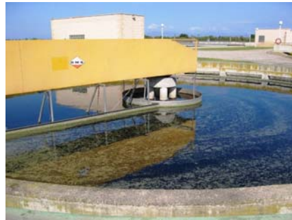
Figura 4.4. Decantador secundari.
