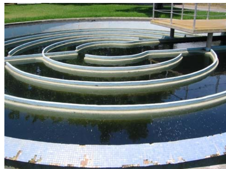
Figura 2.7. Etapa d'afinament de l'aigua regenerada. Post-cloració.
