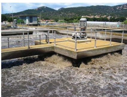
Figura 4.19. Reactor biològic.
