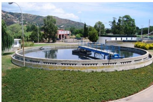
Figura 4.18. Decantador primari.
