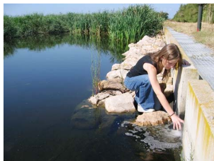
Figura 4.8. Punt d'entrada de l'aigua procedent de l'EDAR al SAC.
