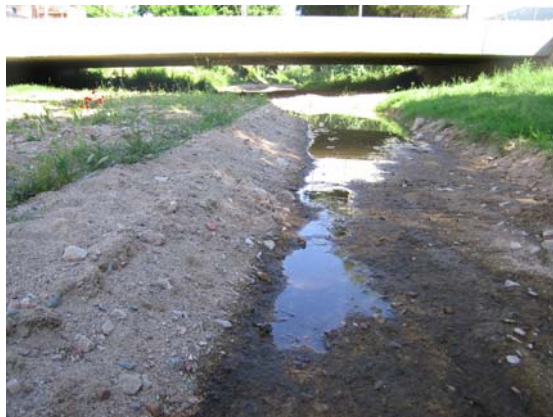
Figura 5. Riera de Tossa a l'alçada de l'hotel Soms Park (To6) el juny de 2007.
