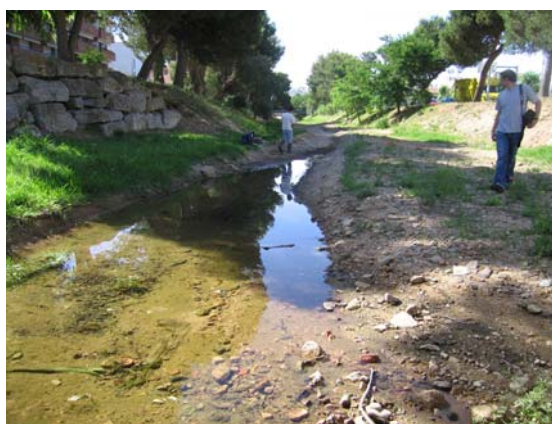
Figura 11. Riera de Tossa a l'alçada de l'hotel Soms Park (To6) el juny de 2007.
