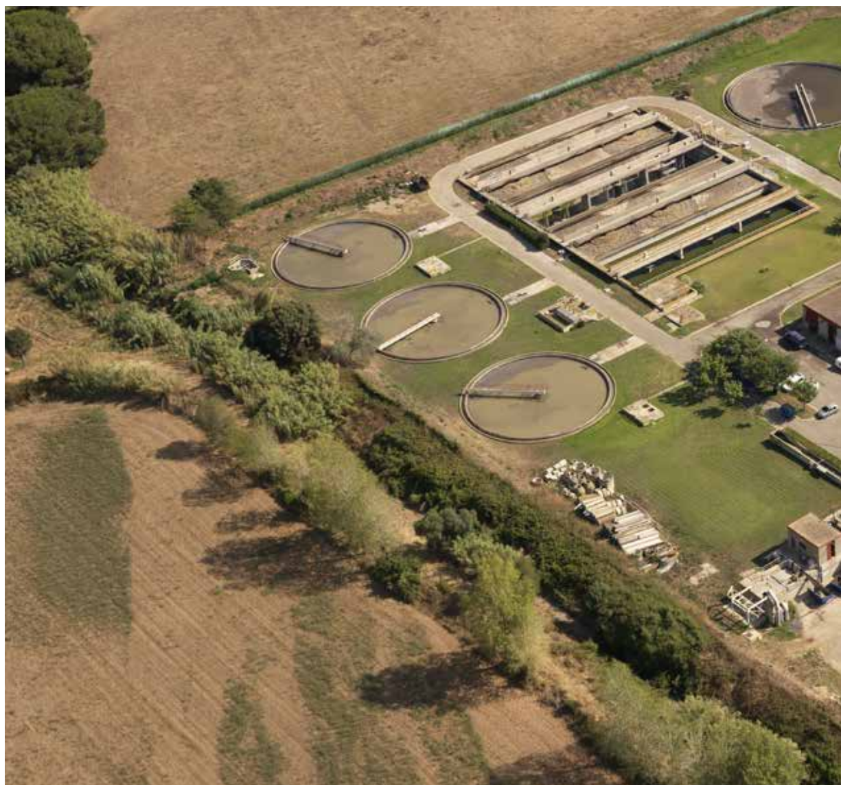
Perspectiva àeria de la depuradora de Palamós, pendent d'una remodelació a fons per modernitzar-la, amb una inversió prevista de 15 milions d'euros. Font: Agència Catalana de l'Aigua.
