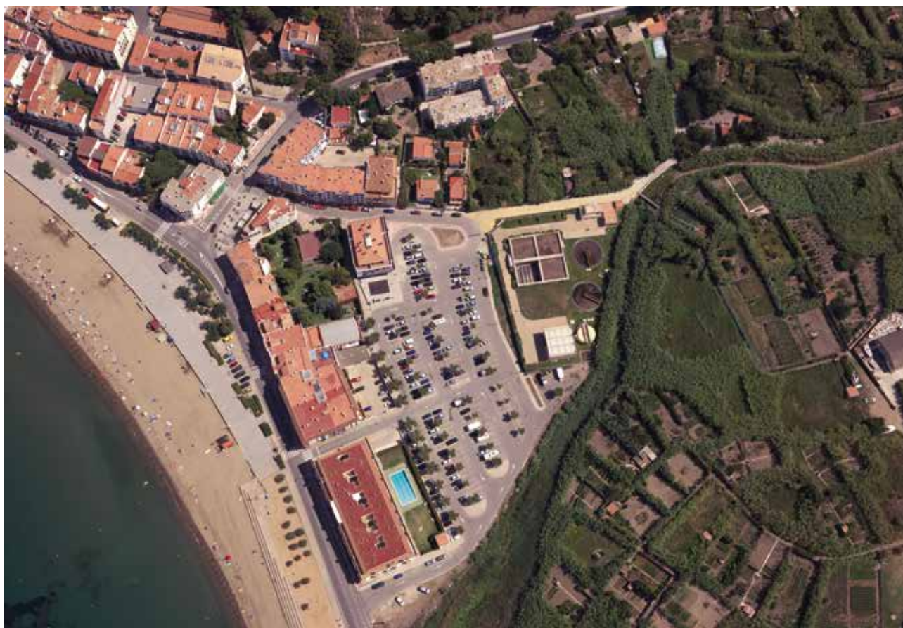
Vista aèria de la depuradora del Port de la Selva. Font: Consorci de la Costa Brava.
