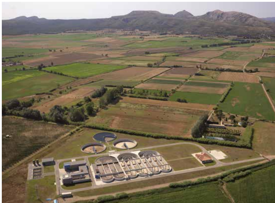
Vista aèria de la depuradora de l'Escala. Font: Consorci de la Costa Brava.
