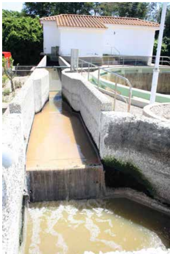
Depuradora d'aigües residuals de Tossa de Mar.
