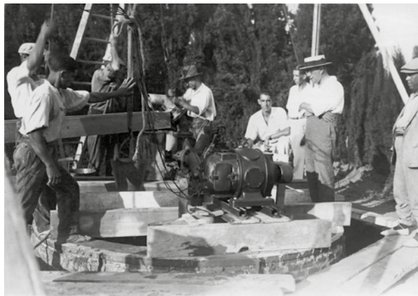
Obres de la construcció del pou del carrer Riera de Sant Joan de Palamós, supervisades per Zoilo Costart, enginyer municipal (1923).
