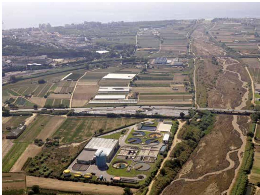
Depuradora de Blanes. Font: Consorci de la Costa Brava.
