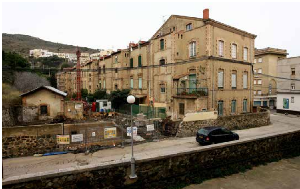
Inici de la construcció de la planta d'osmosi inversa (dessalinitzadora) per a un pou municipal, al costat de l'estació de Renfe. Portbou (2009). Font: Ajuntament de Girona. CRDI. Fons El Punt (Manel Lladó Aliu).
