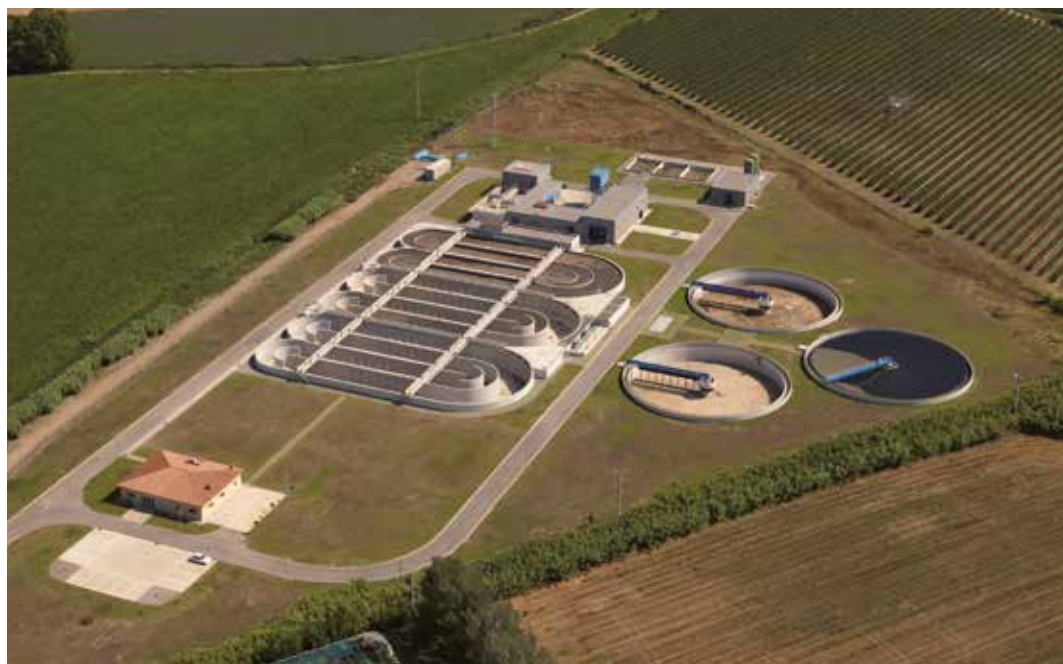
Vista aèria de la depuradora de l'Escal. Font: Consorci de la Costa Brava.
