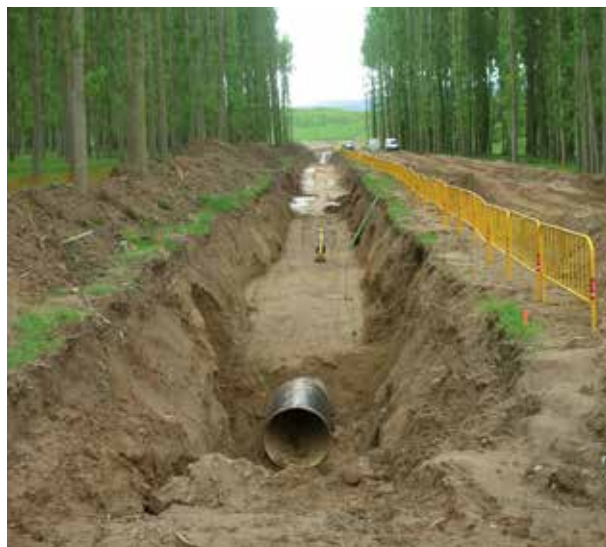
Obres de construcció de la canonada del Pasteral, que es va posar en funcionament l'any 1993.
