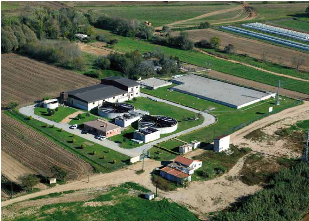
Vista aèria de la potabilitzadora de Lloret de Mar i Tossa de Mar a Tordera. Font: Consorci de la Costa Brava.
