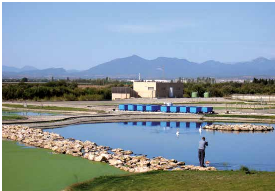
Sistema de llacunatge de l'estació depuradora d'Empuriabrava.
