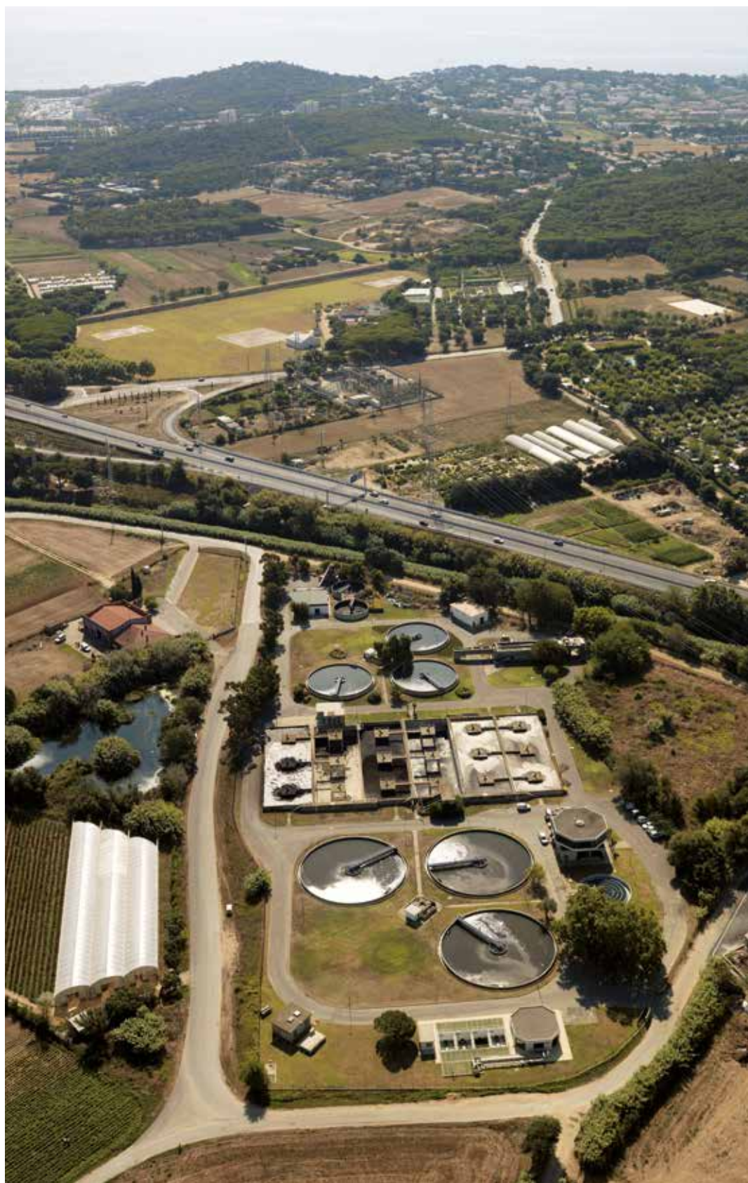
Vista aèria de la depuradora de Castell-Platja d'Aro. Font: Consorci de la Costa Brava.
