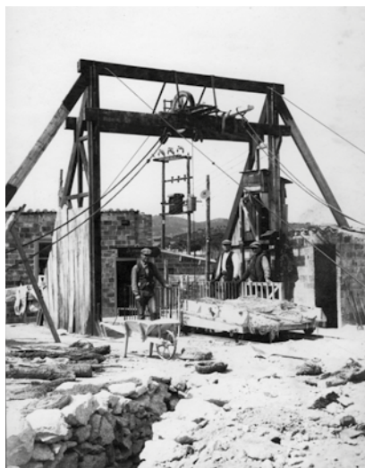
Treballs de perforació del pou de la Granota, 1925-1928.
