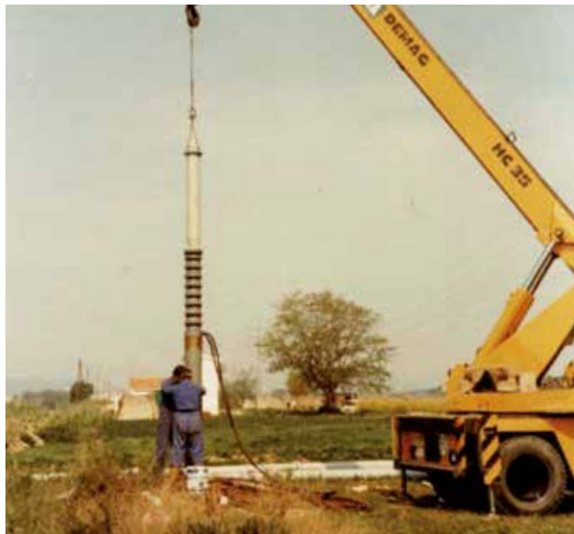
Reparació dels pous per a l'abastament de Tossa de Mar a la Tordera.
