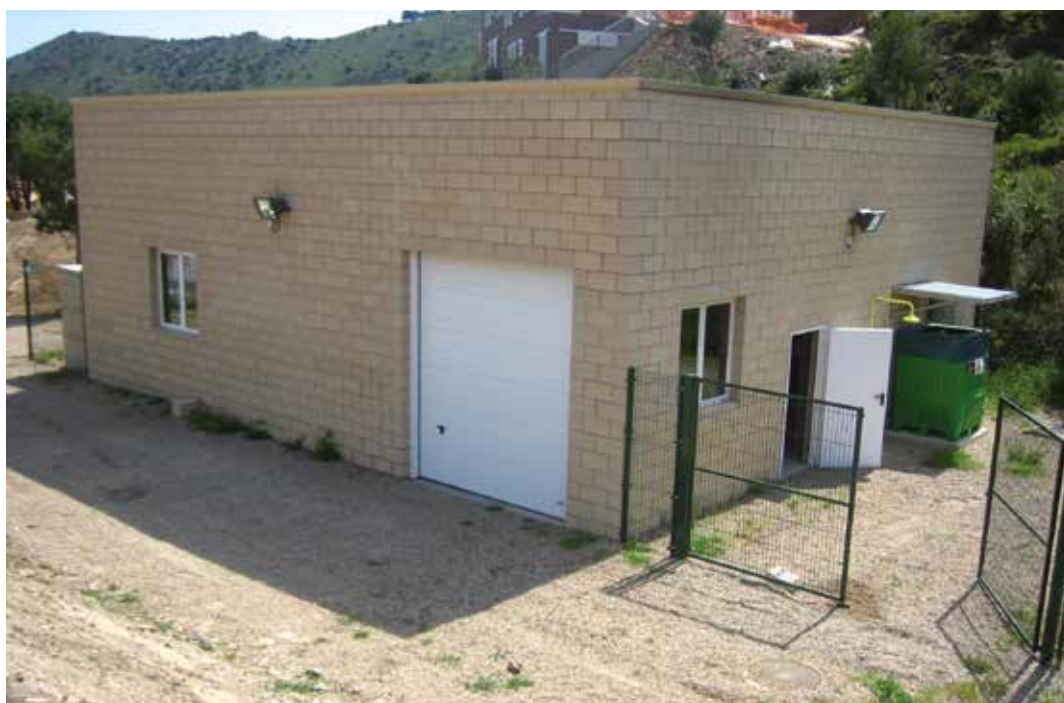
Planta d'osmosi inversa de Colera. Font: Agència Catalana de l'Aigua.
