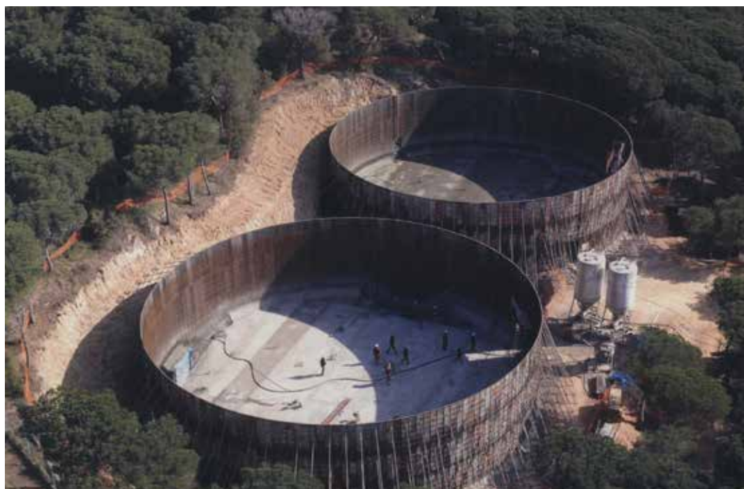
Construcció de dos dipòsits de 4.000 m 3 d'aigua cadascun per incrementar per cinc la regulació i reserva d'aigua de Sant Feliu de Guíxols.
