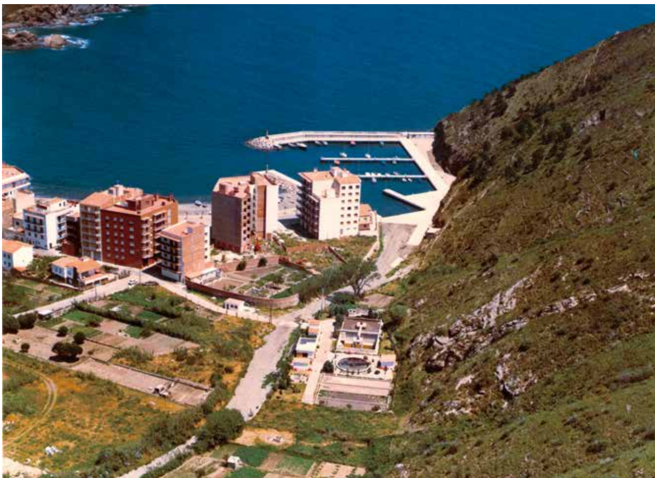
Vista de l'estació depuradora d'aigües residuals de Colera. Font: Consorci de la Costa Brava.
