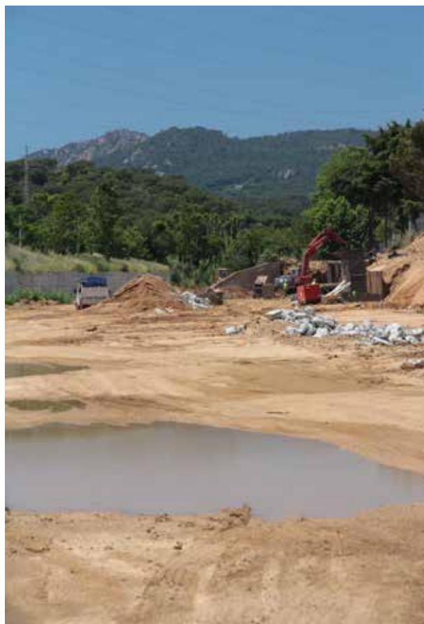
Obres d'endegament del riu Ridaura, davant la depuradora de Castell d'Aro. Font: Ajuntament de Girona. CRDI. Fons El Punt (Emili Agulló).
