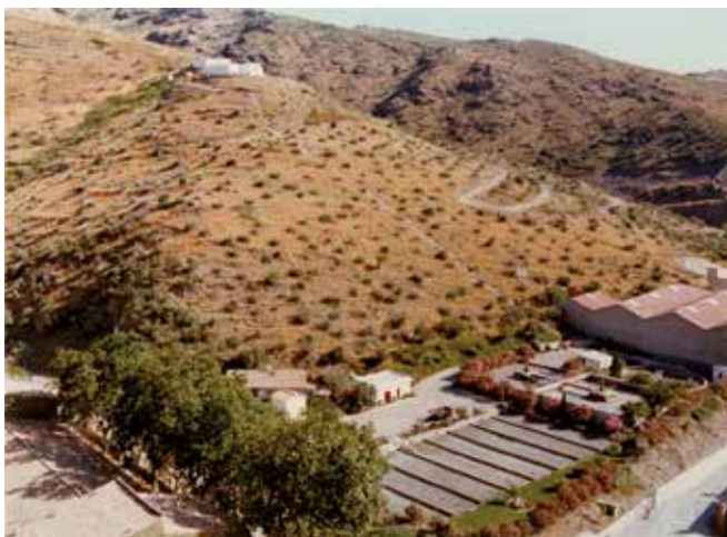
Vista de la depuradora de Portbou, abans de la remodelació de finals dels anys noranta. Autor: Marian Roman.
